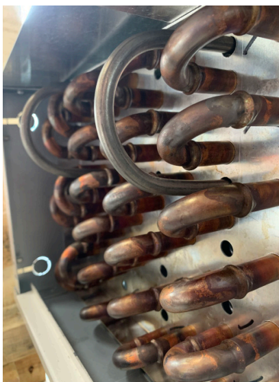
Gevinde warmtewisselaar met epoxy coating
